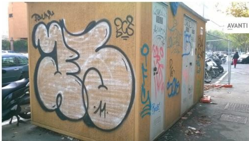
Cabina Enel via Gramsci - prima della riqualificazione Image 1 of 7
