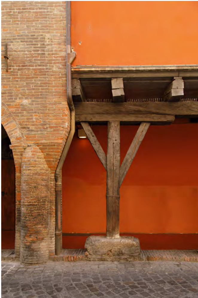
Fig. 10: Detail of the portico of Casa Venenti, Via Marsala 17.
