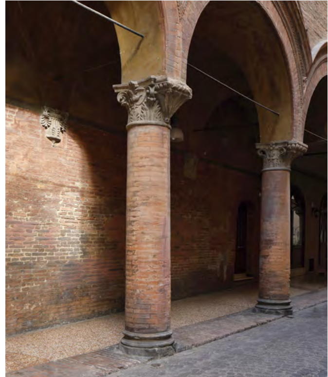
Fig. 23: Portico of Palazzo Caccialupi in Via Volturno.
