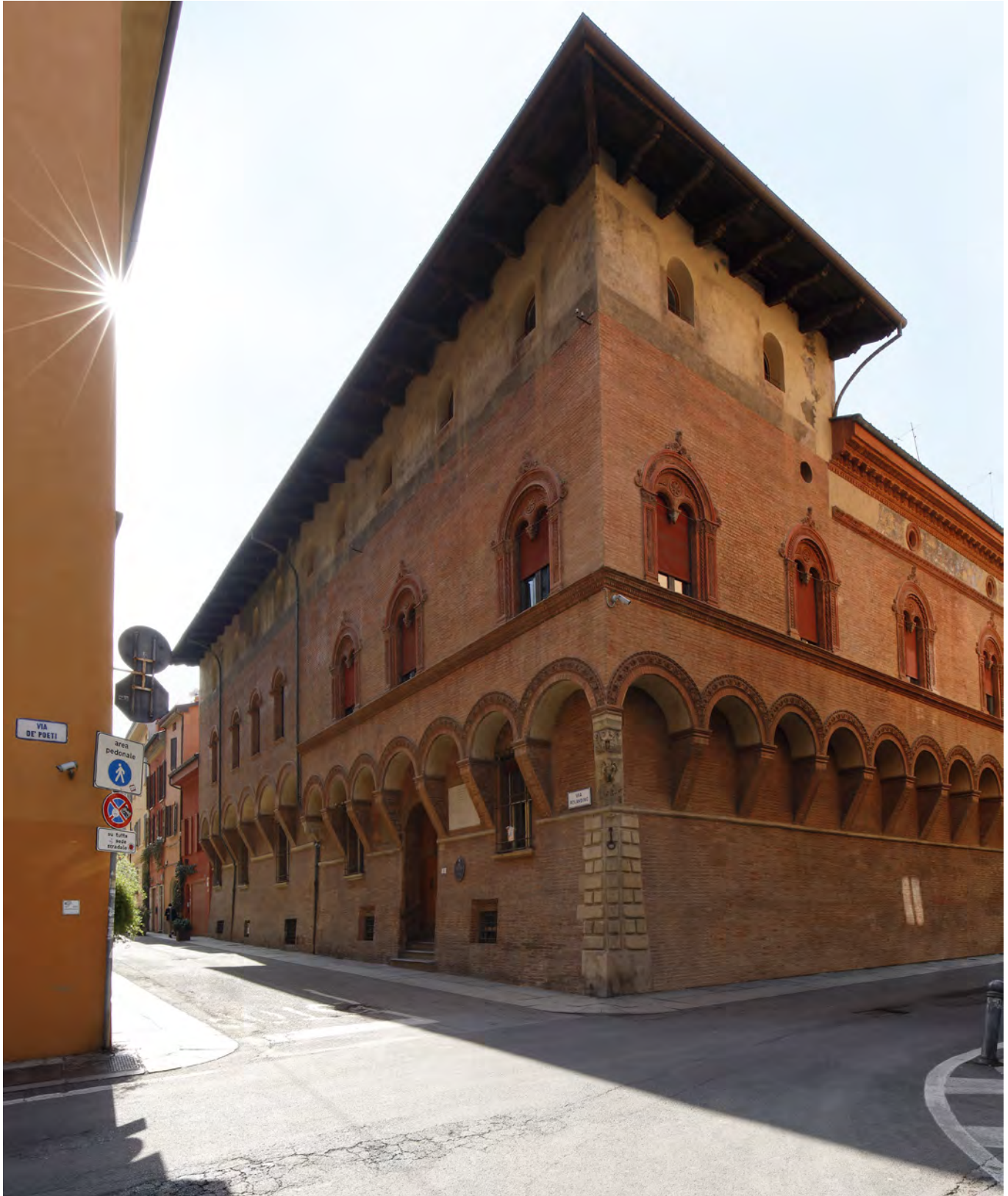
Fig. 22: View of Casa Berò, Via Rolandino 1.
