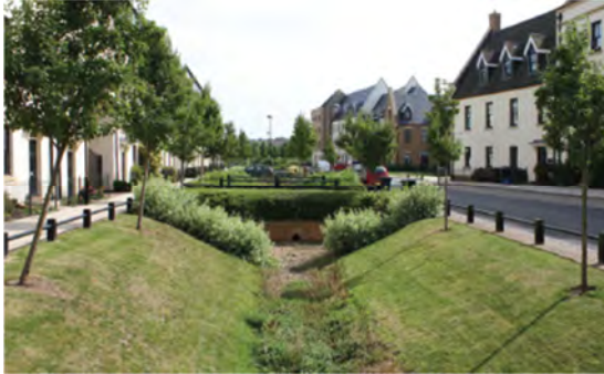
Esempio di canale vegetato asciutto
